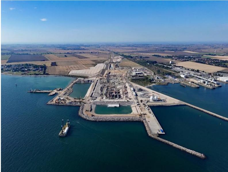
**Abb. 4:** Ende August 2024: Der vorderste Abschnitt der Portalbaugrube an der Küste Fehmarns konnte geflutet werden. Im Anschluss folgte der Rückbau des temporären Rückhaltedamms. Seitdem liegt der vorderste Tunnelabschnitt unter Wasser, der in offener Bauweise entstand. Foto: Sund & Bælt Holding A/S
