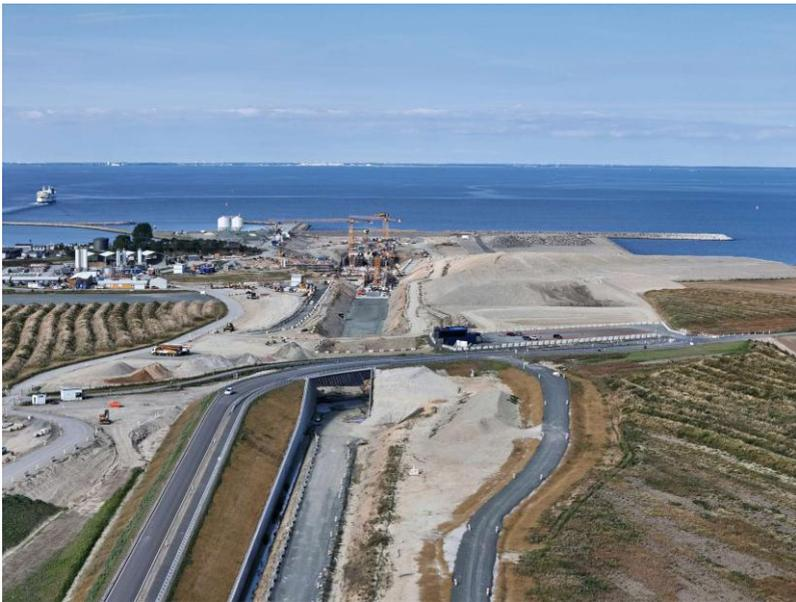
**Abb. 5:** Der Portalbereich auf deutscher Seite im August 2025. Im Vordergrund die Brücke über die neue Bahntrasse in Richtung Tunnelleinfahrt. Auf der anderen Seite des Fehmarnbelts ist die Tunnелеlementfabrik in Rødbyhavn erkennbar. Foto: Sund & Bælt Holding A/S.
