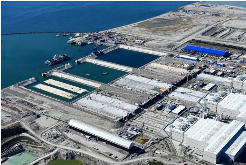
**Abb. 3:** Die Produktionsanlage in Rødbyhavn mit den Becken vor den Fabrikhallen sowie dem großen Arbeitshafen. Im Hintergrund befindet sich das dänische Tunnelportal. Foto: Sund & Bælt Holding A/S
