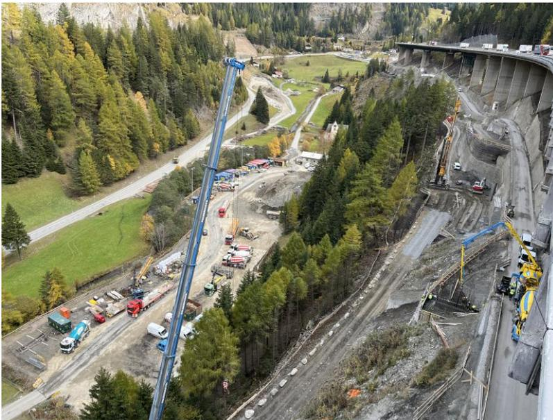
**Abb. 6:** Gründungsarbeiten talseitig der Bestandsbrücke
