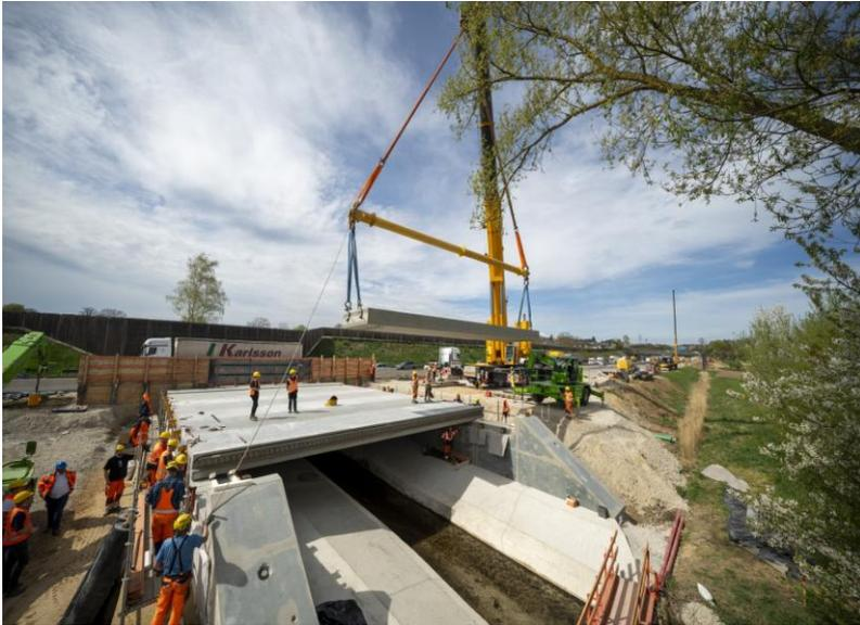
**Abb. 3:** Modulmontage, Lenting. Quelle: Firmengruppe Max Bögl
