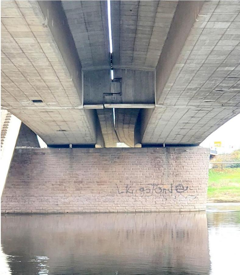
Abb. 4: Querkraftgelenk zwischen den Zügen a und b (Foto: Silke Scheerer)
