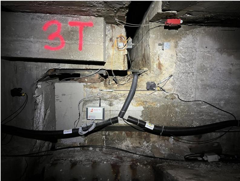
**Abb. 4:** Ausbildung Tragwerksfugen - Tragwerkskonsole
