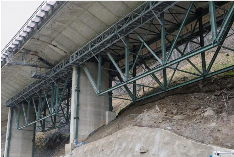
**Abb. 5:** Tragwerkssicherung
