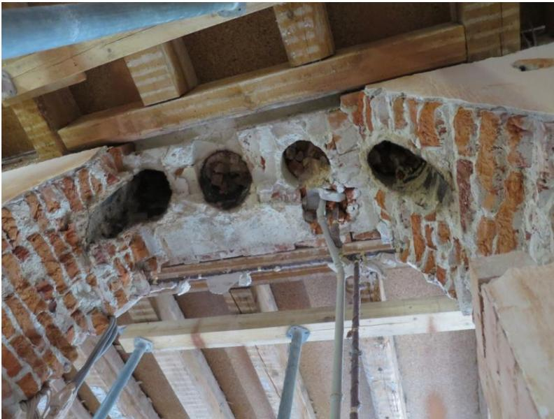
**Abb. 6:** Bauzeitlichen Kaminzüge im Mauerwerk
