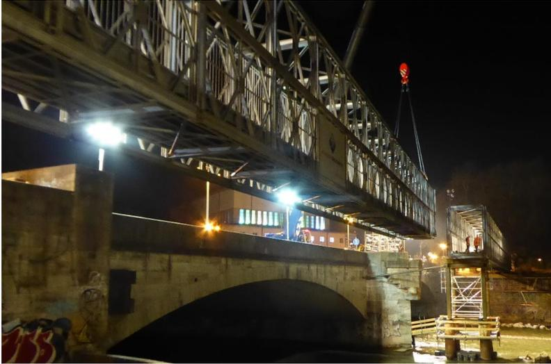
**Abb. 15:** Einhub der Behelfsbrücken nördlich und südlich der Äußeren Ludwigsbrücke
