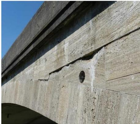
**Abb. 7:** Risse und Hinterläufigkeit im Brüstungsbereich
