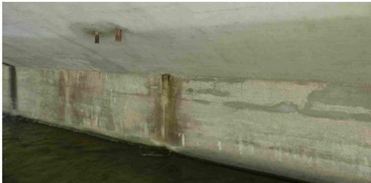
**Abb. 5:** Feuchteschäden an einem Kämpfergelenk
