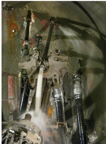
**Abb. 3:** Drainagebohrung 2013 gegen 5 bar Wasserdruck
