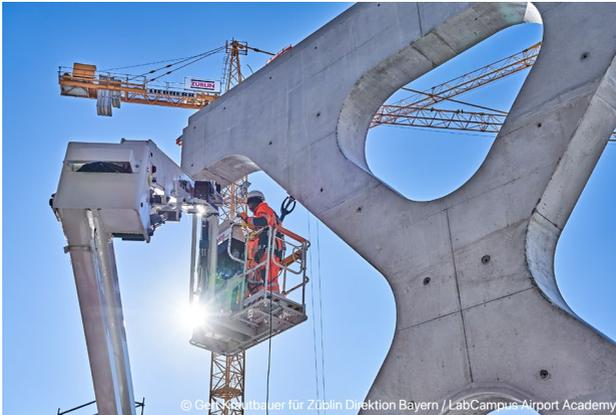
**Abb. 1:** Hergestellter Takt des Betonaußenfachwerks
