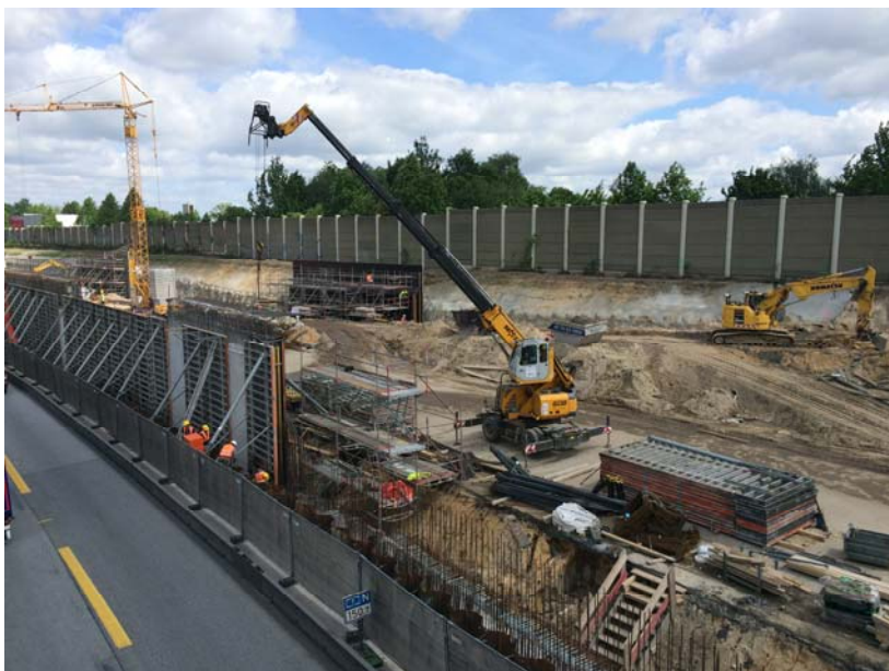
Abbildung 4: Schalen und betonieren der Tunnelinnenwände [eigenes Foto]
