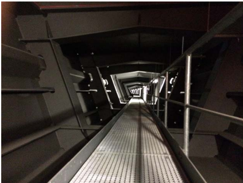
Abbildung 2: Innenansicht des östlichen Hohlkastens [eigenes Foto]
