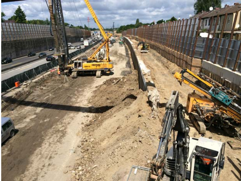
Abbildung 3: Einbringen der Tiefengründung für die Tunnelinnenwände im Abschnitt Stellingen [eigenes Foto]
