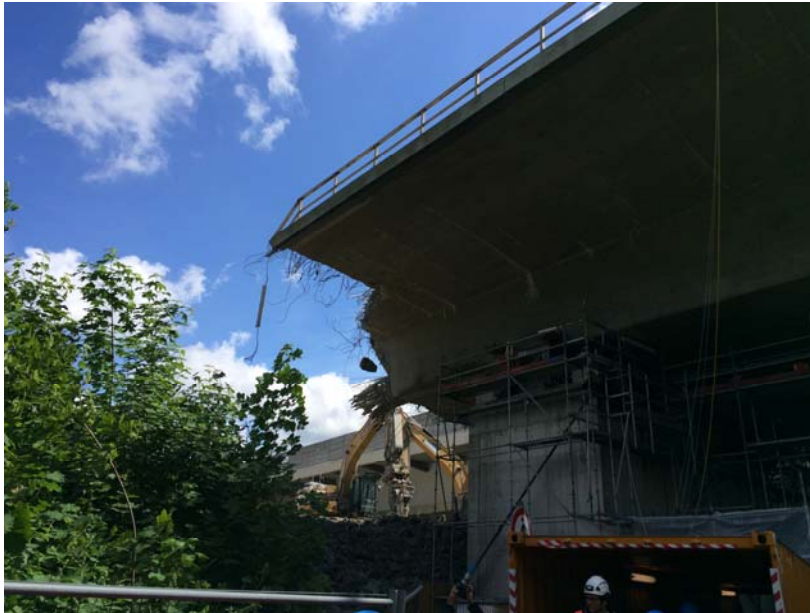
Abbildung 2: Ausschub und Abbruch des westlichen Überbaus [eigenes Foto]
