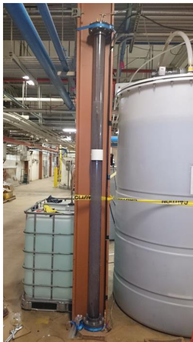
Abb. 10: Versuchsaufbau der Strippingsäule im Aufbau (Mitte) an der Pilotanlage in Delta Diablo neben dem CANDO-Reaktor (weißer Tank rechts)
