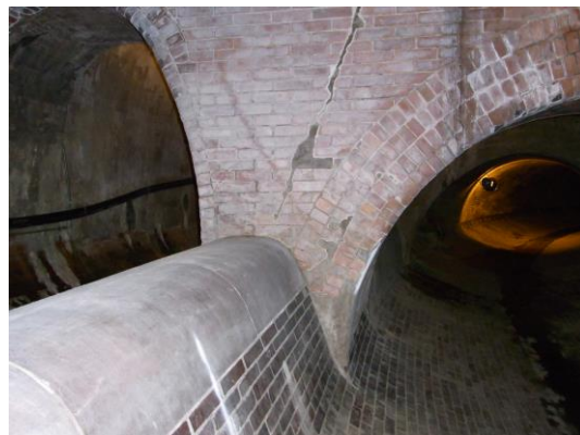
Abb. 20: Beispiel eines begehbaren Kanals
