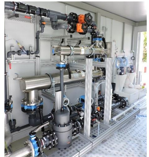
Abb. 39: UV/H<sub>2</sub>O<sub>2</sub> Pilotanlage im Klärwerk Gut Marienhof (München II).
