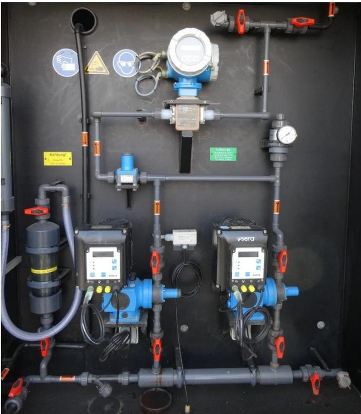
**Bild 22: Fällmitteldosierstelle der Kläranlage Musterdorf 2 mit zwei Pumpen (regelbar in Bezug auf die ortho-Phosphatkonzentrationen im Ablauf der Biologie) und einem MID zur Durchflussmessung**
