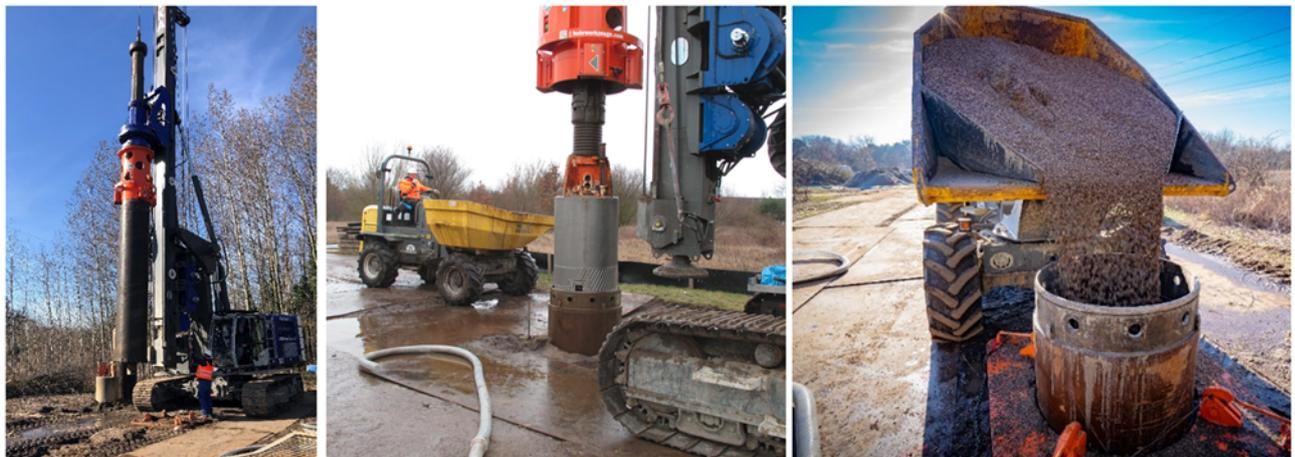
**Abb. 19** Herstellung des Sickerschlitzen grabens und Einbringung des Filtermediums in Berlin-Johannisthal (Bildquelle der rechten Abbildung: Sven Bock / Berliner Wasserbetriebe).
