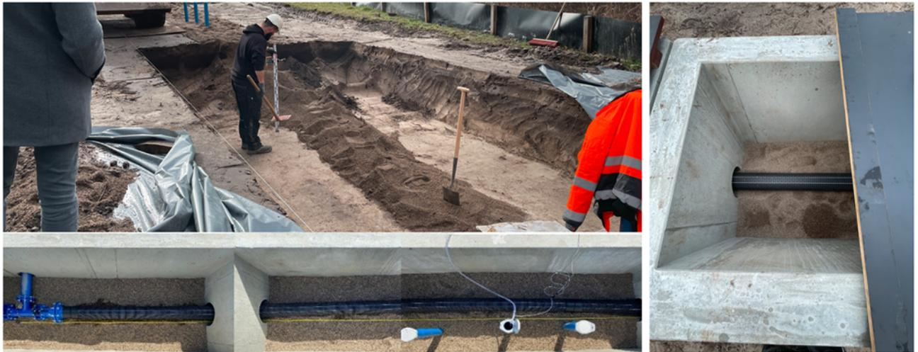
Abb. 20 Offener Sickerschlitzgraben und Positionierung des Abschlussbauwerkes.
