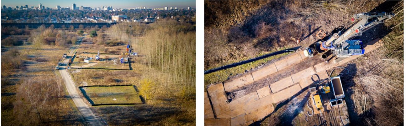
**Abb. 18** Baustelleneinrichtung zum Bau des Sickerschlitzen grabens in Berlin-Johannisthal (Bildquelle: Sven Bock / Berliner Wasserbetriebe).
