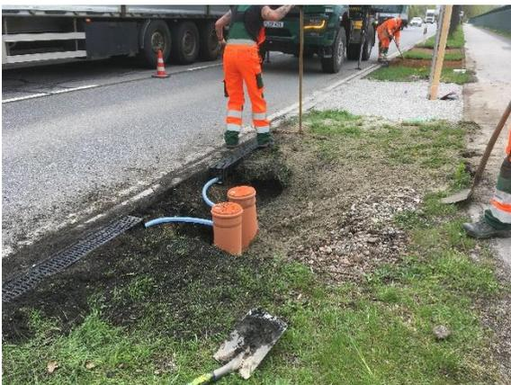
Einbau der Rinnen zur Zulaufprobenahme (27.04.22)
