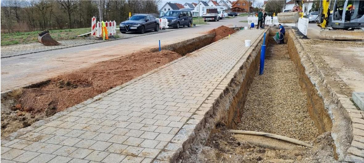
Einbau der Kiesdrainage in Variante A (rechts) und des Substrats (06.04.22)
