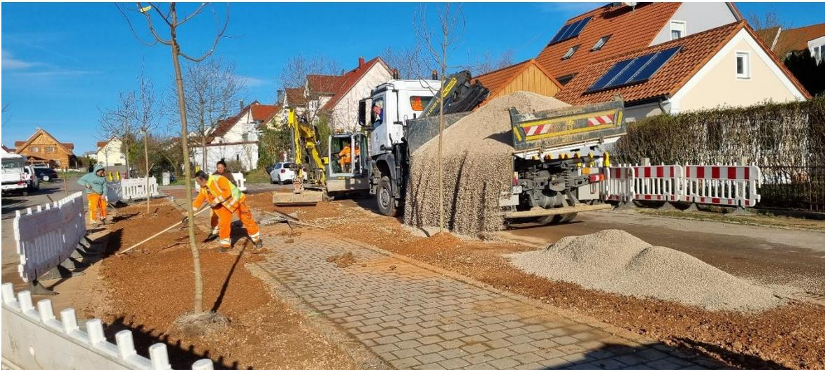
Pflanzung der *Acer opalus* und Einbau der Splittschicht als mineralischen Mulch (07.04.22)
