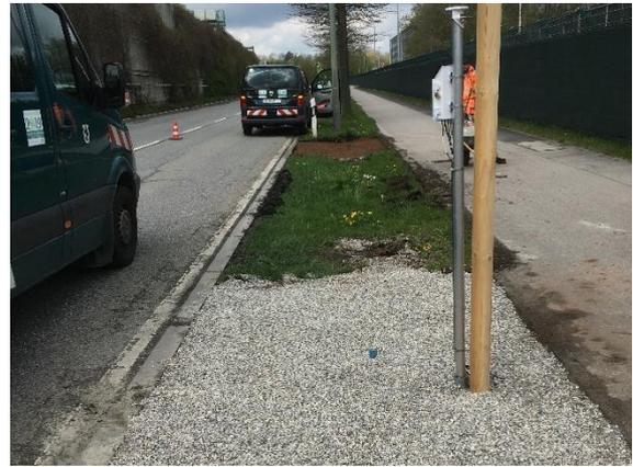
Einbau der mineralischen Mulchschicht aus Splitt und der Masten für Messtechnik und Datenlogger (27.04.22)
