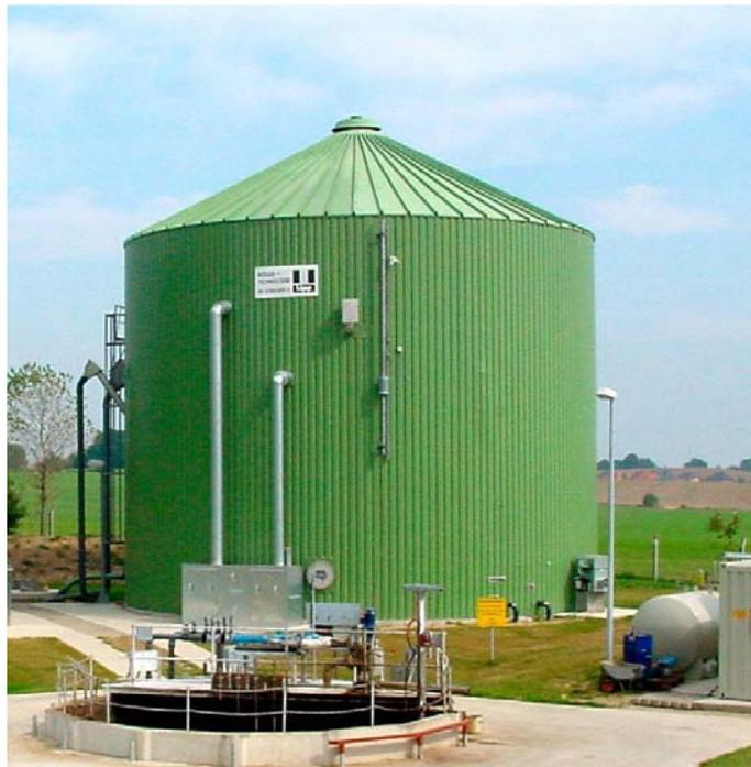
**Abbildung 73: Faulbehälter mit integriertem Gasraum in Stahlbauweise mit Blockheizkraftwerk (BHKW) in Containeraufstellung der Fa. Lipp GmbH, Tannhausen (aus Meyer und Biebersdorf (2008): Bilddokumentation der Fa. Lipp GmbH)**
