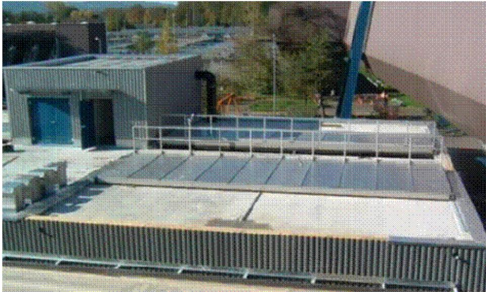
**Abbildung 57: Reaktoren PNAA Werdhölzli (ERZ (2008))**
