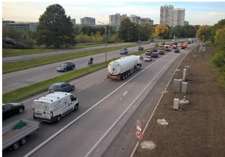
Abbildung 9: Dezentrale Behandlungsanlage von Strassenentwässerungsabläufen
