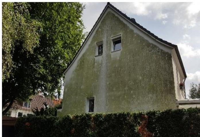
Abbildung 10: Biozide inhibieren unerwünschten Bewuchs auf Gebäudefassaden
