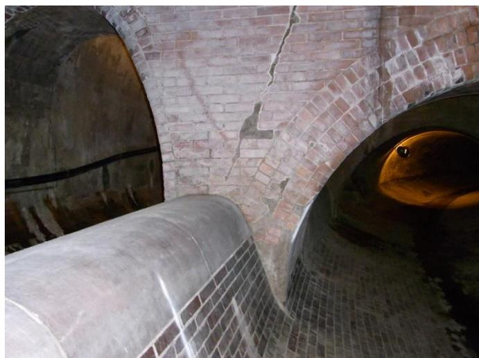
Abbildung 12: Beispiel eines begehbaren Kanals
