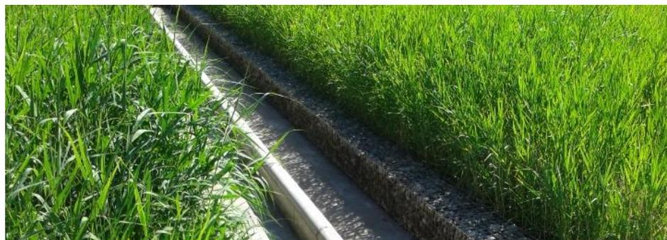
*Abbildung 5: Beispiel eines Retentionsbodenfilters zur Behandlung von Straßenanflüssen.*
