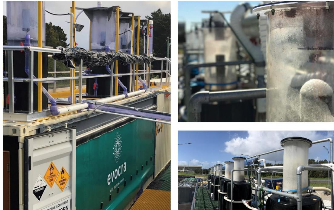
**Abbildung 5:** Fotografien großtechnischer Umsetzungen der Ozonfraktionierung (Bildquellen: [18,22,23]).
