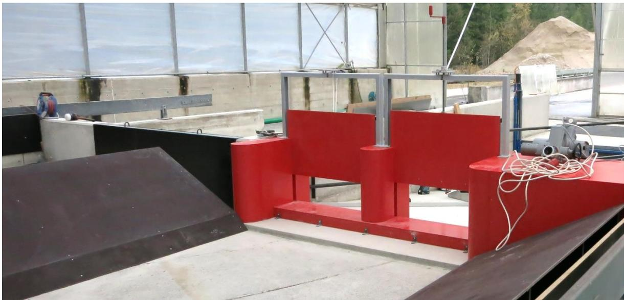
**Abbildung 16: Sperrenbauwerk mit baugleichen Wehrfeldern zur Stauregelung in der Aufbauphase**
