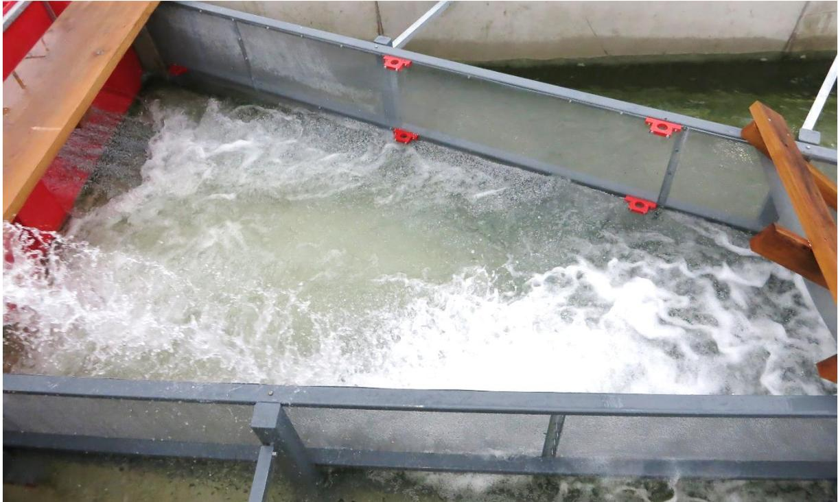
**Abbildung 48: Sedimentfang im Betrieb**
