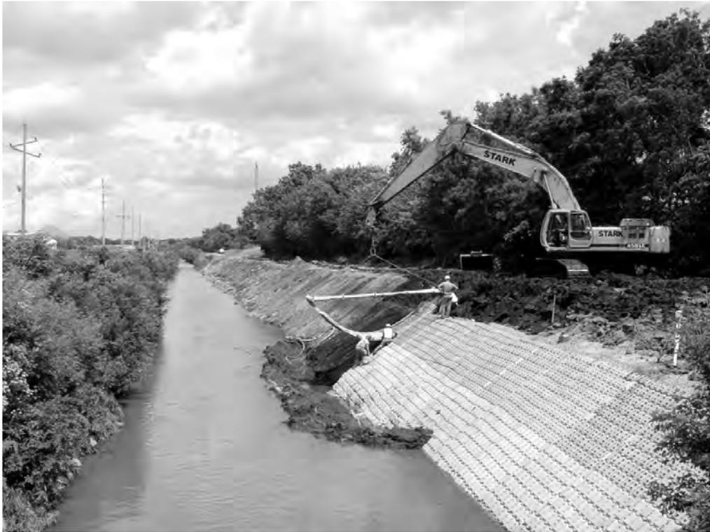
Abb. 6.17: Einbau eines kabelgebundenen Verbundsteinsystems zur Ufersicherung (aus Armortec, 2007)
