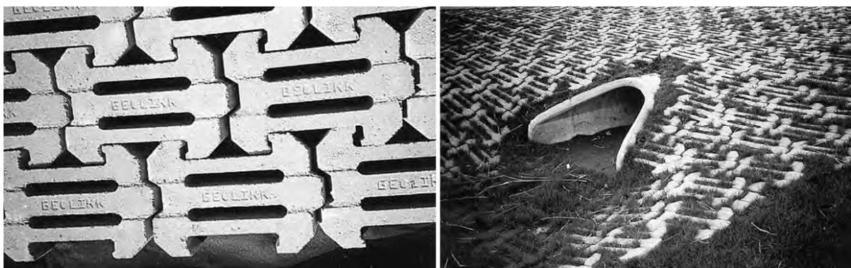
Abb. 6.16: Betonsteine mit Verzahnung (aus King's Material Inc., 2007)
