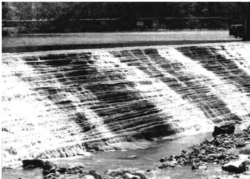
Abb. 6.15: Überströmung des mit RCC saniert ausgeführten *Ocoee No. 2 Dam* in Tennessee (Hansen und France, 1986)
