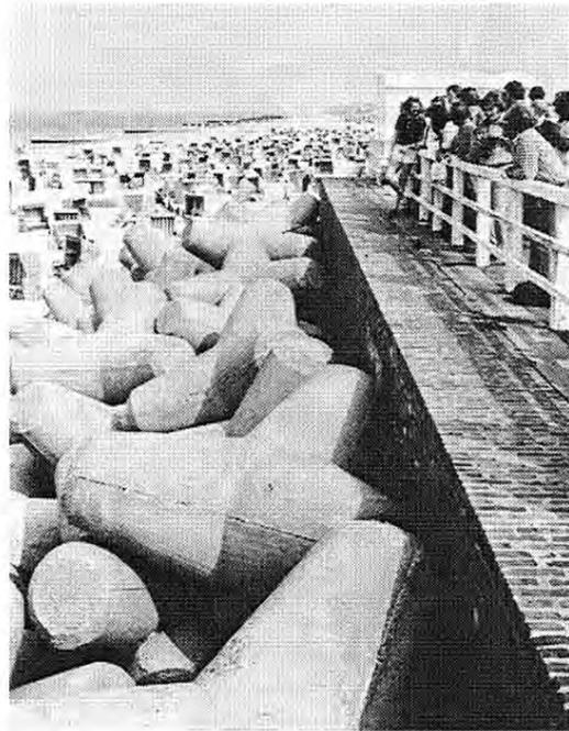
Abb. 6.10: Ausführungsvarianten für Wasserbausteine aus Beton (links) und Küstensicherung an der Strandpromenade in Westerland/Sylt (aus Partemschky, 1996)
