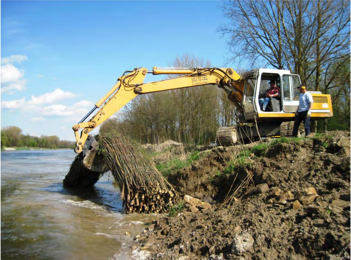
**Abb. 3** Einbau der Weidenfaschinen (WWA Ingolstadt)
