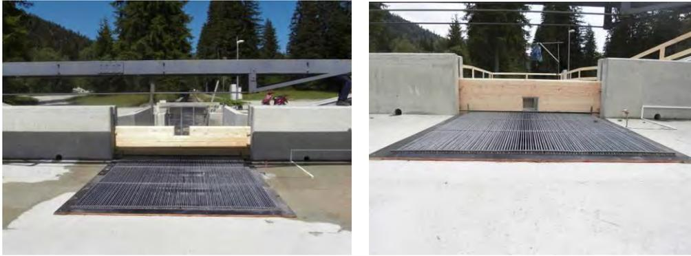
**Abb. 2** Ansichten der Verschluss- bzw. Fischabstiegsvarianten vom Oberwasser, oberflächennahe Variante (links) und sohlnahe Variante (rechts)
