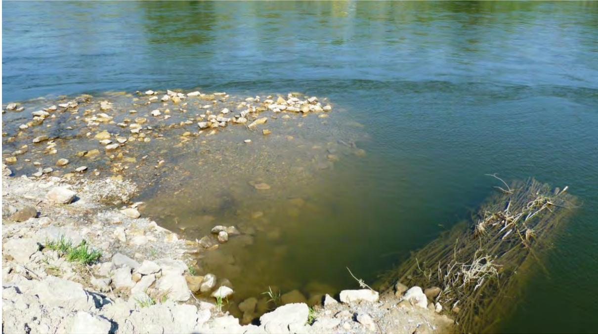
**Abb. 2** Überströmter Sporn mit Faschinenbündel (WWA Ingolstadt)
