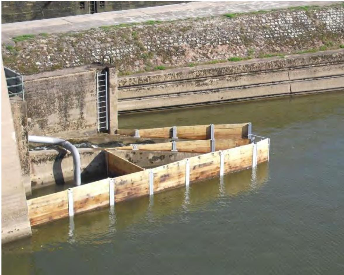
**Abb. 6** Lockstrompumpe an der FAA in Lengfurt
