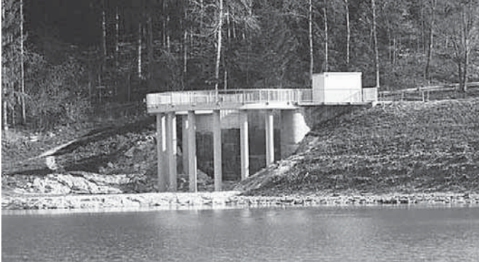
Abb. 4.8: Neuer Schwemmholzrechen (Prototyp)
