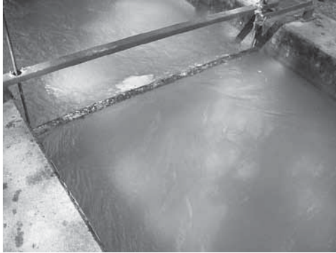
Abb. 3.18: Rundholz senkrecht zur Fließrichtung, das an den Gewindestangen in der Mitte des Vorbodens zurückgehalten wird
