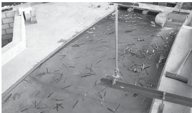
Abb. 4.35: Schwemmholzabfuhr bei vollständig geöffneter HWE ohne Kraftwerksbetrieb
