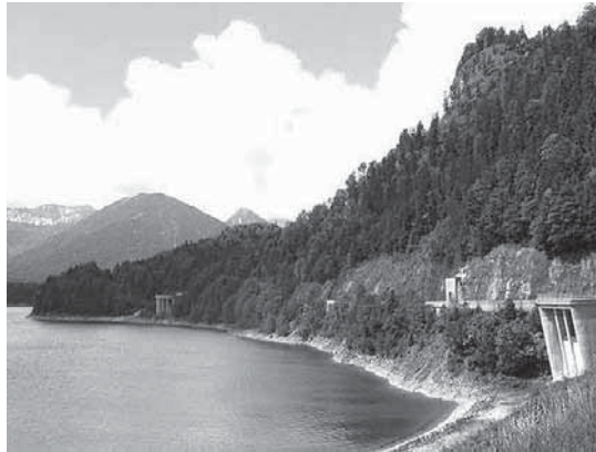
Abb. 4.15: Einlaufbauwerk der nachgerüsteten alten HWE1 im Prototyp
