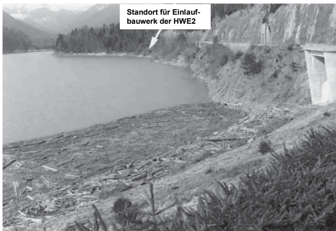
Abb. 4.13: Schwemmholzteppich vor Damm und Einlaufbauwerk der HWE1
