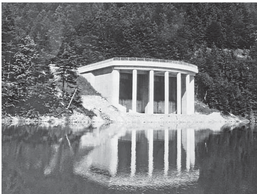
Abb. 4.19: Einlaufbauwerk der zusätzlichen neuen HWE2 im Prototyp
