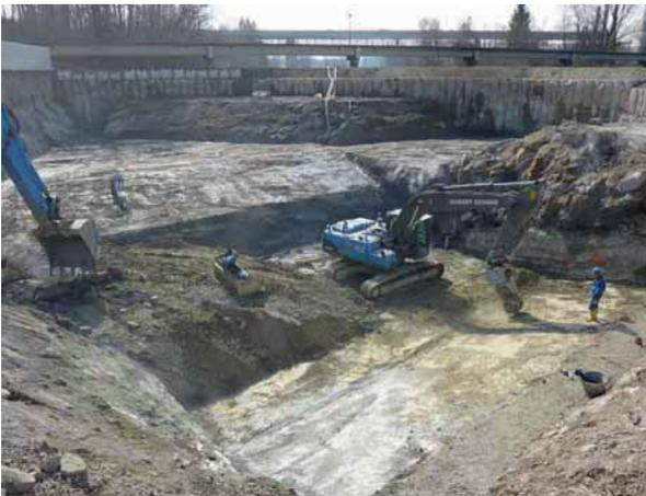
**Abb. 7** Die Baugrube für die Tröge des Kraftwerkes
