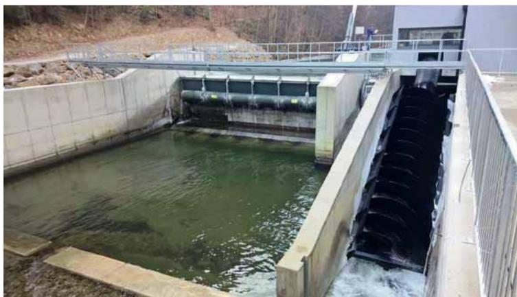
**Abb. 3** Restwasser-Wasserkraftschnecke beim KW Stubenberg/Feistritz
