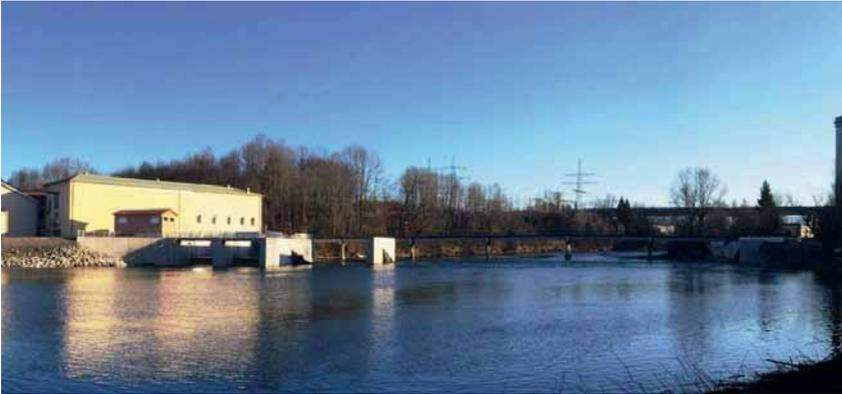
**Abb. 8** Fertiggestellte Anlage bei abgesenktem Schlauchwehr, Ansicht vom UW
