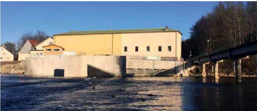
**Abb. 9** Fertiggestellte Anlage bei abgesenktem Schlauchwehr, Ansicht vom Ufer rechts
