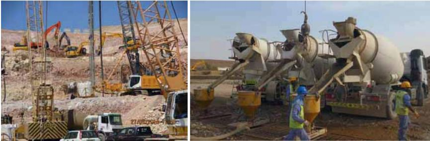
**Abb. 8** Fräsen der Schlitzwand im Hang (links), Betonieren der Schlitzwand im Kontraktorverfahren (rechts)
