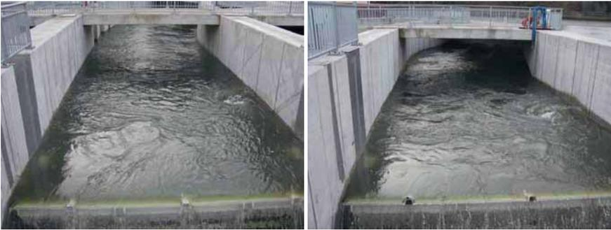
**Abb. 5** Anströmung der beiden Turbinen im Original für den maßgebenden Lastfall (Blick entgegen der Fließrichtung, links: in Fließrichtung rechte Turbine)
