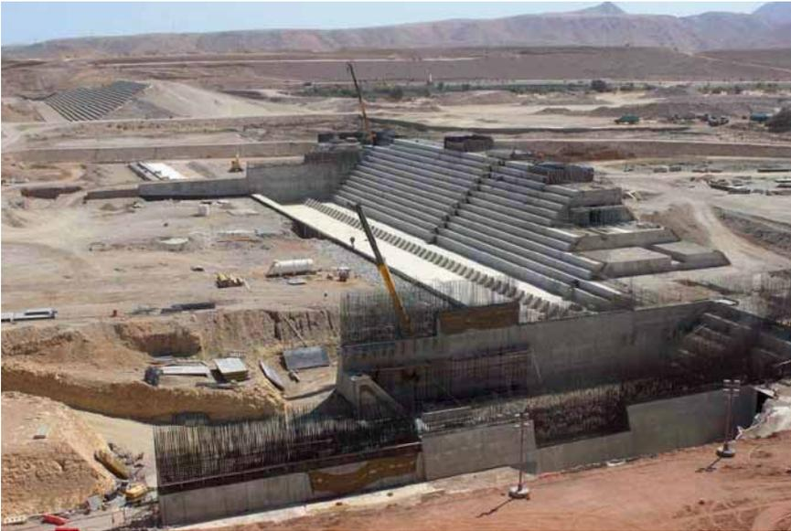
**Abb. 10** Bauarbeiten Hochwasserentlastung und Grundablass
