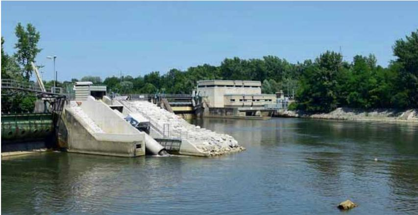
**Abb. 8** Wasserkraftschnecke der Verbund Hydro Power GmbH an der Sulm beim KW Retznei (Wehranlage links im Bild, rechts das Mur-KW Obervogau)
