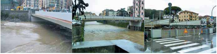
Abb. 2. Neue Hubbrücke am Torrente Boate. Links: Hochwasserereignis. Mitte: Angehobene Brücke (von oberstrom). Rechts: Angehobene Brücke (vom angrenzenden Platz)
