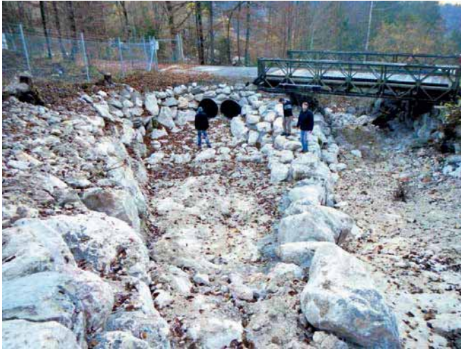
Abb. 11 Bypass 2x DN1400 zur Sicherung des Abflusses bei Brückenverkläusung
