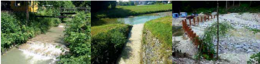
Abb. 5. Links: Die Große Laine in Oberammergau. Mitte: Die Einmündung der Großen Laine in die Ammer. Rechts: errichteter V-Rechen oberhalb der Rückhaltesperre.
