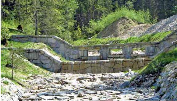
Abb. 6: sanierte Vorsperre
