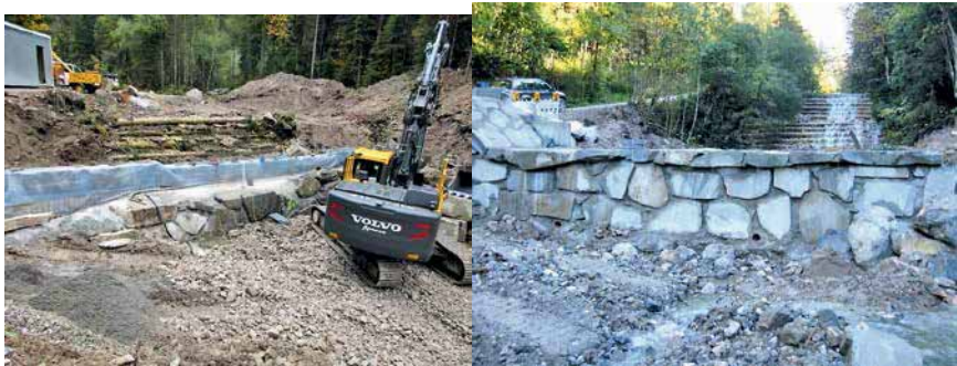
Abb. 17 – 19 :Sanierung und Umbau schadhafter Holzsperrren
