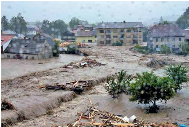
Abb. 5: Abflusssituation an der Wilhelm-Dieß Straße um 13:12. Der linksufrige Deich ist an zwei Stellen gebrochen, trotzdem erfolgt ein bordvoller Abfluss in den Inn. Das Wasser strömt aus dem Rückstau vor dem Bahndamm Durchlass (im Bild links) über das Gerinne in den Polder Erlach (Quelle: Gschneidner, L.)
