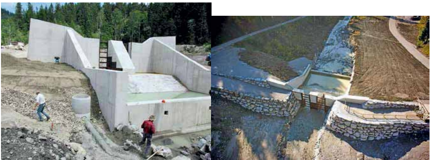
Abb. 10 – 16: Bau der Geschieberückhaltesperre
