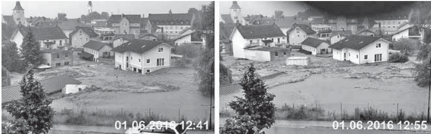
Abb. 4: Vergleich der Abflusssituation im Bereich des Einlaufbauwerks (Quelle: Köck, G.) (links:unbeeinflusster Hochwasserabfluss; rechts: Hochwasserabfluss überlagert mit dem Breschenabfluss)
