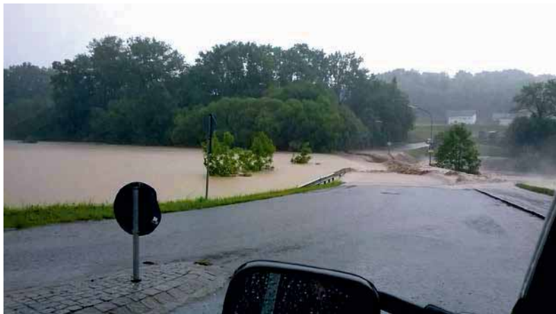
Abb. 3: Damm Schulstraße um 12:37 kurz vor dem Versagen (Quelle: Blöchl, M.)
