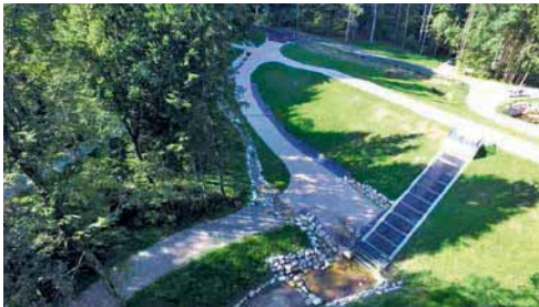
Abb. 2 Einlaufbauwerk mit Schwemmholzrechen
