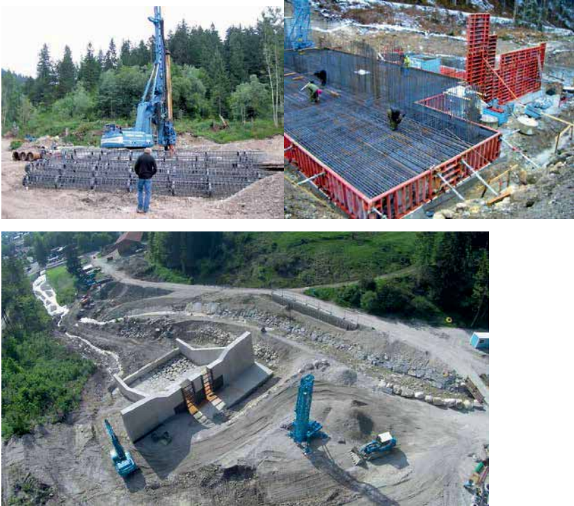
Abb. 10 – 16: Bau der Geschieberückhaltesperre
