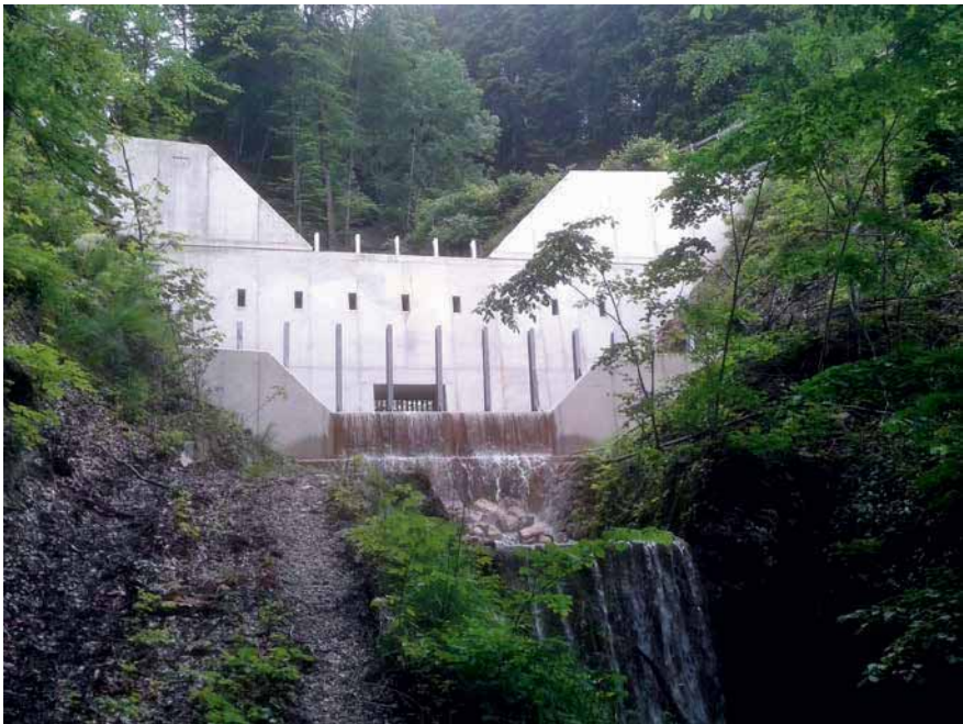
Abb. 5 Sperrenbauwerk mit Schwemmholzrechen am Freidinggraben
