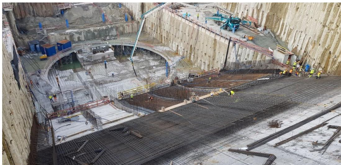
**Abb. 5** Ausgeführte Baugrube mit Ringrost (Bild Firma Porr GmbH)
