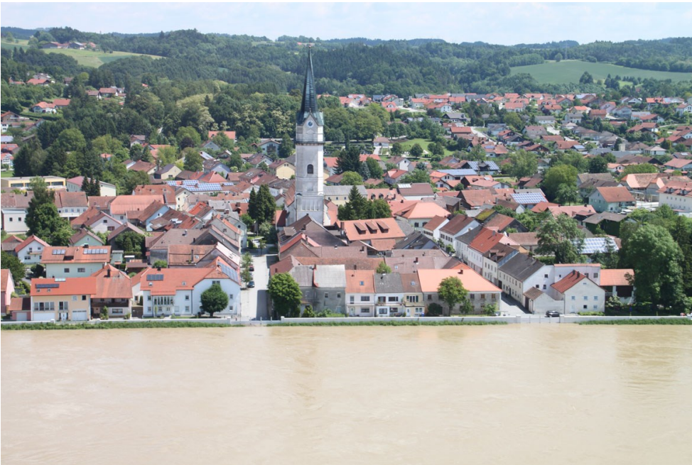
Abb. 2 Hochwasserschutz an der Donau in Hofkirchen
