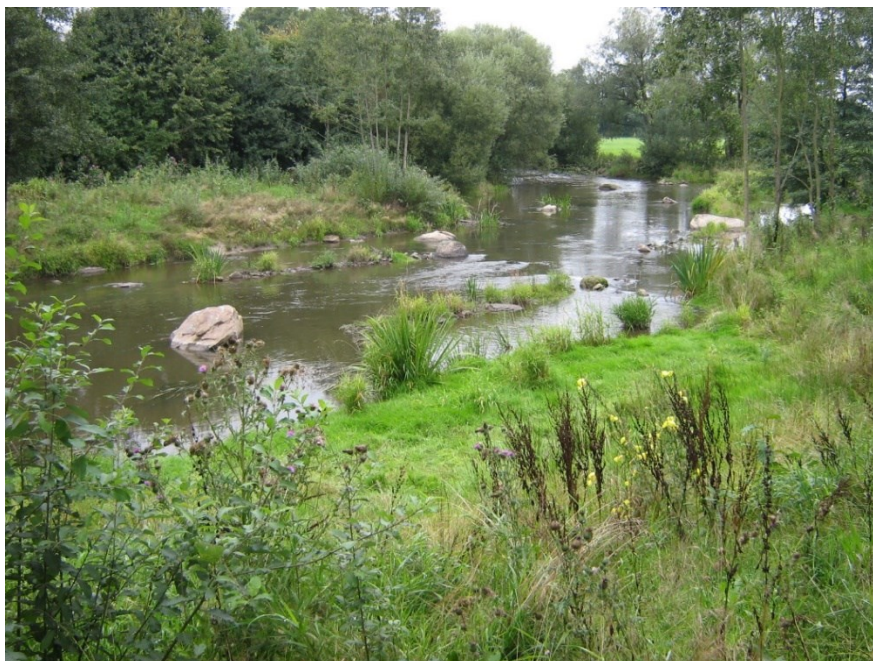
Abb. 3 Renaturierungsmaßnahmen (Störsteine und Leitwerke) an der Schwarzach (Oberpfalz)
