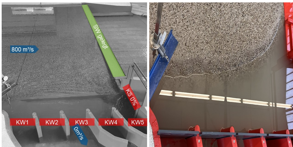
Abb. 9 links: Darstellung der Betriebssituation mit modifizierter Anlagensteuerung; rechts: erheblicher Geschiebeeintrag in die Kiesfalle
