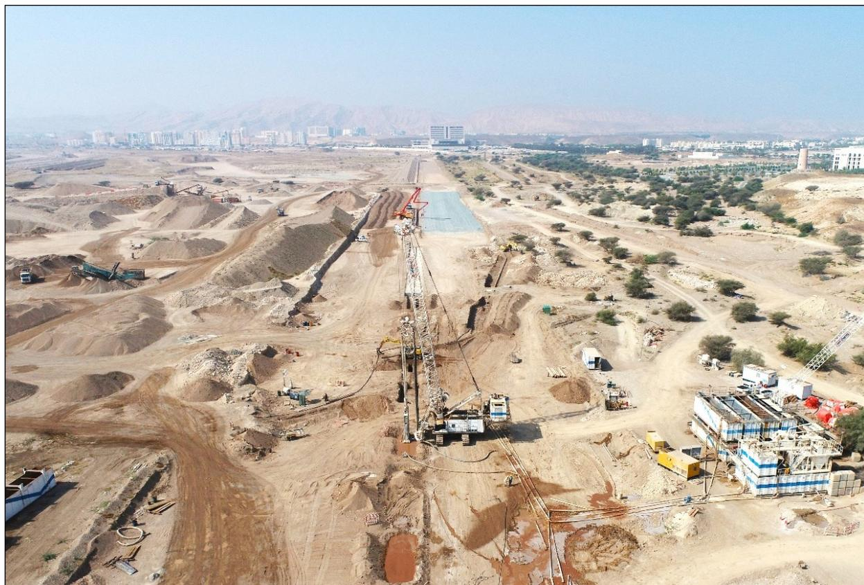
**Abb. 5** Schlitzwandarbeiten mit Hydrofräse und Bentonitsuspension
