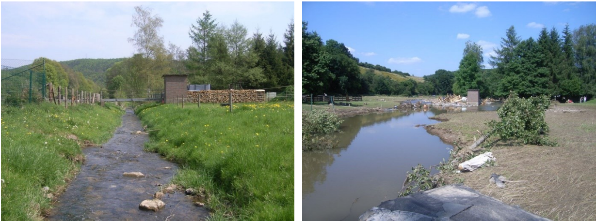
Abb. 1 Pegel Schönau im Erft Einzugsgebiet: links intakt vor und rechts zerstört nach dem Hochwasserereignis (Quelle: Erftverband)
