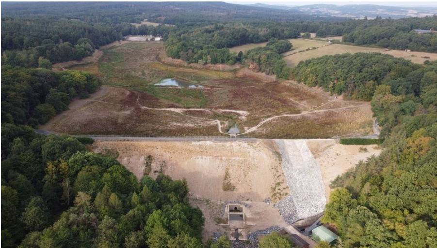
Abb. 3 Die leere Steinbachtalsperre mit umgestaltetem Damm im Sommer 2022 - ein Jahr nach dem Hochwasser (Quelle: Thomas Becker, e-regio)
