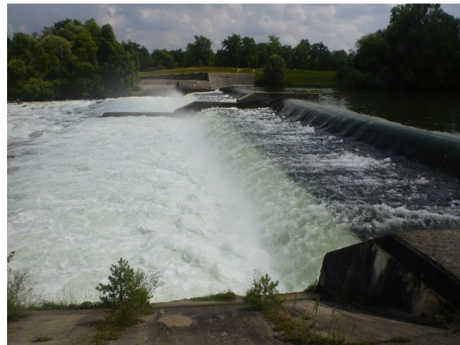
Abb. 5 Einer von sechs Abstürzen
