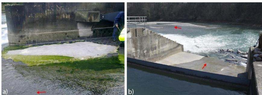
**Abb. 2** Tiefauslass Oberer 1 der Matteschwelle: a) Hydroabrasiver Verschleiss der Sohle im wandnahen Bereich des rechten Wehrpfeilers. Initial herausgeschlagene Schmelzbasaltplatten förderten die Ausdehnung des Schadens (Quelle: ewb); b) sanierte Sohle aus UHFB (Aufnahme während Referenzvermessung im März 2017)
