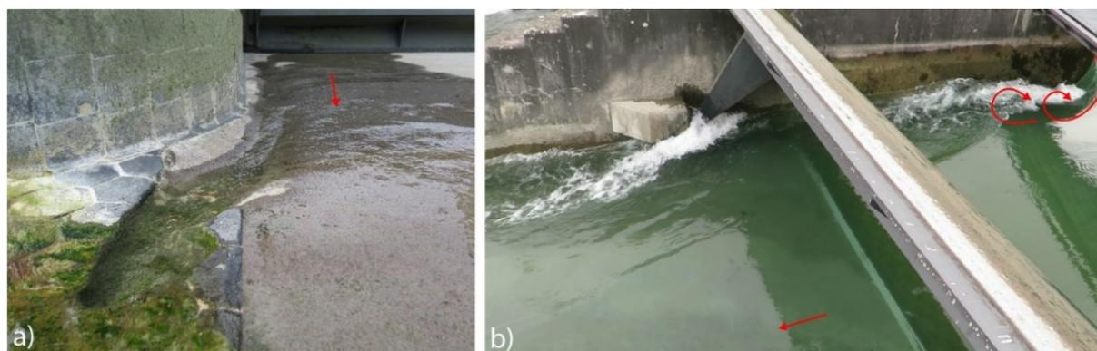
**Abb. 4** a) Abrasionsrinne im UHFB im wandnahen Bereich zum orographisch rechten Wehrpfeiler des Tiefauslasses Oberer 1, Jahr 2022; b) Strömungsablösung am Pfeilerkopf bei komplett geöffneter Drucksegmentschütze
