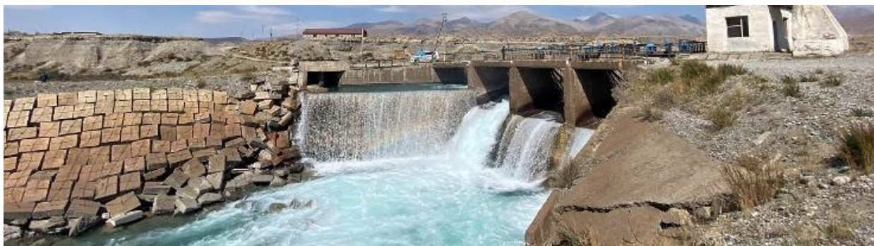
Abb. 1 Wehr der Bewässerungsausleitung At-Bashy
