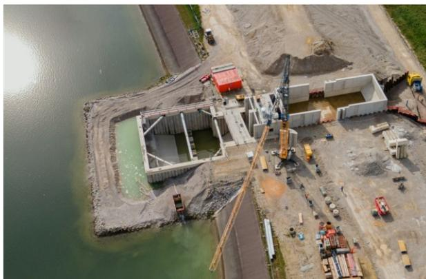
**Abb. 3** Leitzach-Unterbecken-3 mit Absperrdamm und Überlaufbauwerk im Bau
