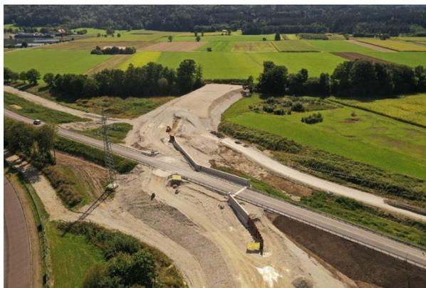
**Abb. 4** Absperrdamm im Bau mit Straßenanhebung Kreisstraße
