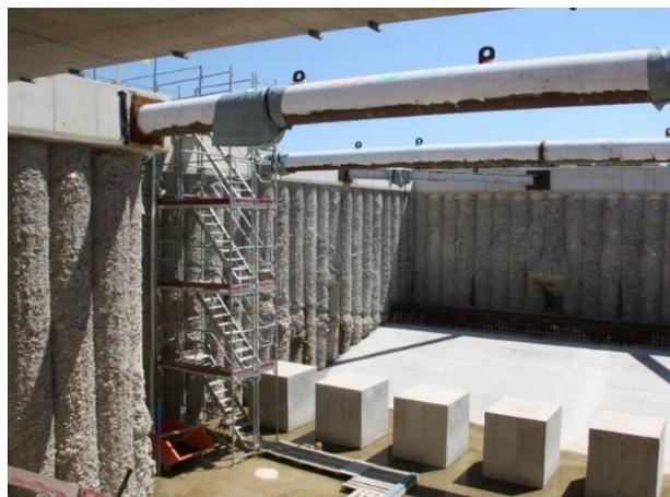
**Abb. 6** fertiggestelltes Tosbecken mit Störkörpern in der ausgesteiften Baugrube
