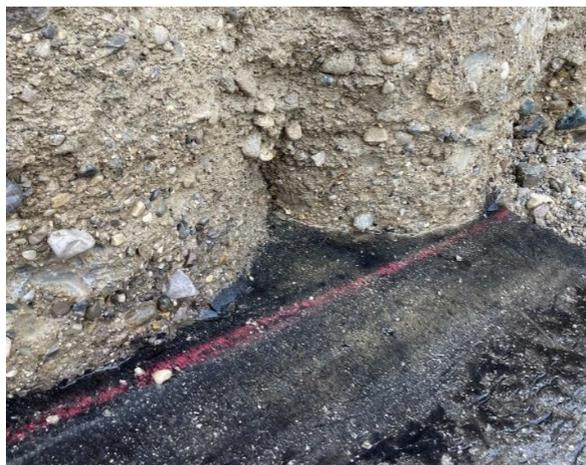
**Abb. 8** guter Verbund zwischen Bohrpfehlen und Asphaltbetondichtung
