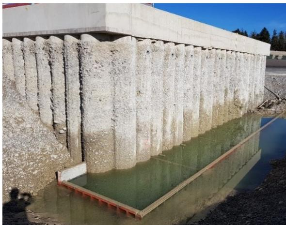
**Abb. 7** Vorbaugrube im Unterbecken 3 mit eingeschalteter Schleppplatte
