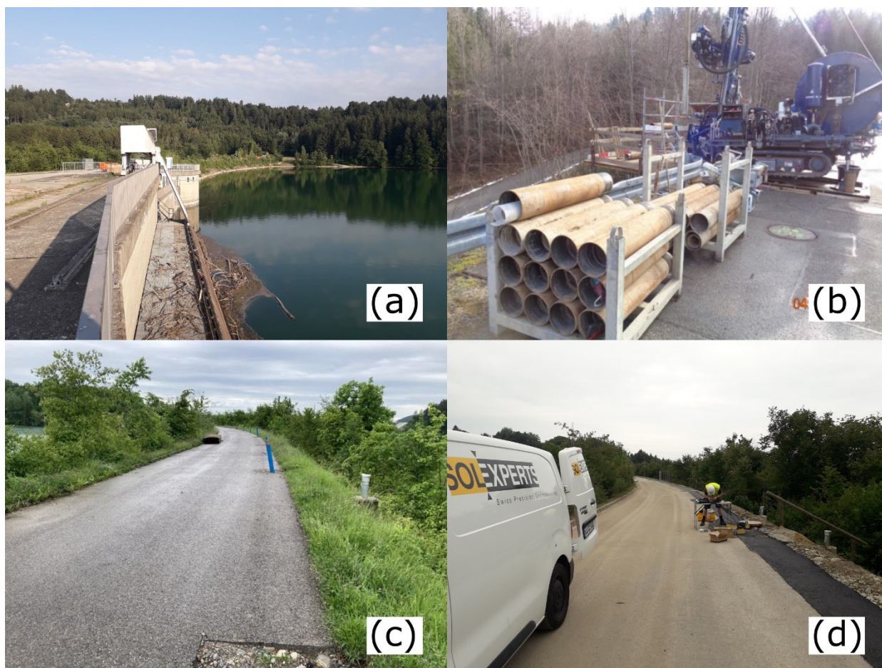
Abb. 1 Talsperre Dornau: (a) Ansicht von Nordwest, (b) Bohrungsarbeiten auf Dammkrone (c) Nach Abschluss Bohrarbeiten (d) Anfertigen Spleißverbindungen
