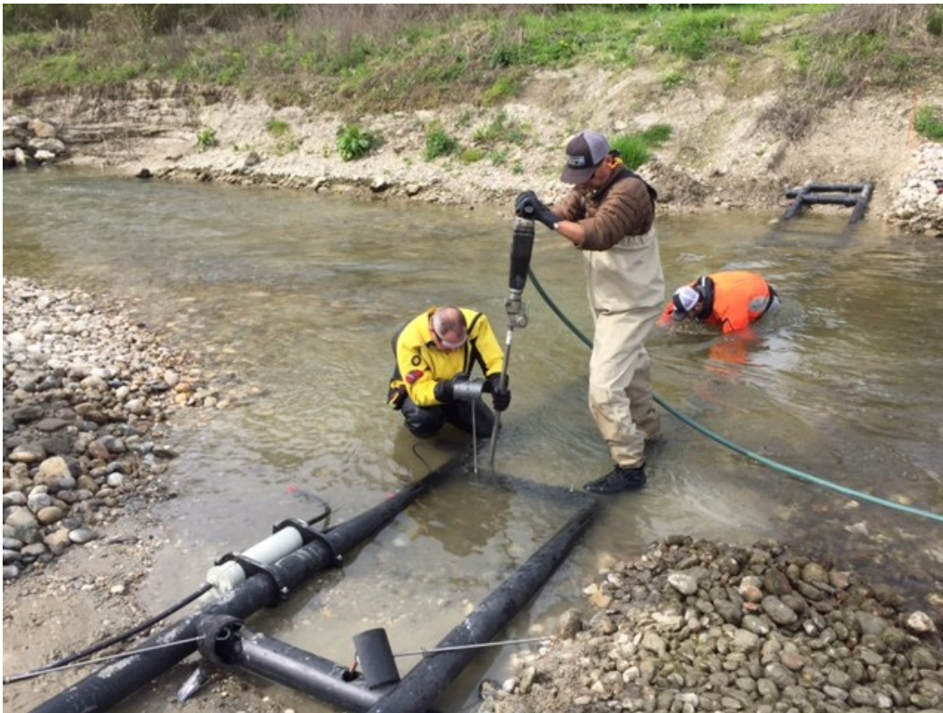
Abb. 1 Montage eines Antennenarrays in der Fischwanderhilfe
