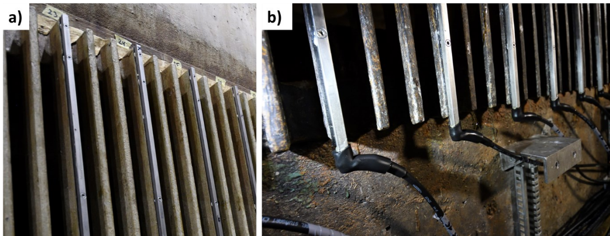
Abb. 5 a) Montage der Elektroden am Bestandsrechen der Wasserfassung am Bestandsrechen am Pilotstandort, b) Anschluss der elektrischen Leitungen am unteren Ende der Stabelektroden
