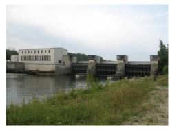
Leistungsfähigkeit der Staustufe unter verschiedenen Randbedingungen und Betriebssituationen zu ermitteln. Der Einfluss der im Stauraum vorhandenen Verlandung auf die Leistungsfähigkeit der Anlage war durch Betrachtung von drei verschiedenen Sohlzuständen einzugrenzen. Darüber hinaus galt es, einen evtl. vorhandenen Einfluss der Unterwasserstände auf das Abflussvermögen zu bestimmen.
