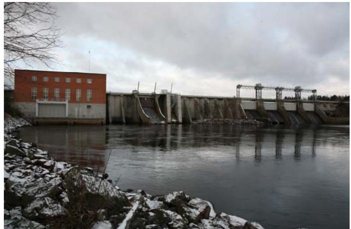
rechten Wehrfeldern 6+7 ist dies durch die Gefahr von starken Erosionen im Unterwasser aufgrund fehlender Energieumwandlungsanlagen begründet. Die Aufgabe des Modellversuchs war daher, die Geometrie der Wehrrückens so zu ändern, dass die sohnahen Geschwindigkeiten im Auftreffbereich der Schussstrahlen möglichst stark reduziert werden. Im Feld 7 war zusätzlich durch die Tiefersetzung der Wehrkrone die Leistungsfähigkeit zu erhöhen.
