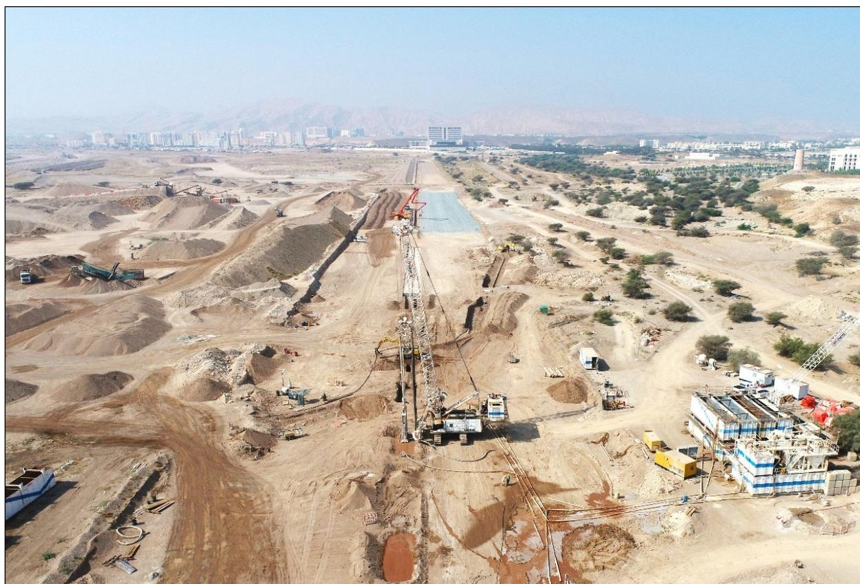
**Abb. 5** Schlitzwandarbeiten mit Hydrofräse und Bentonitsuspension
