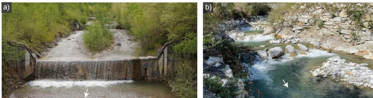
**Abb. 1** a) Wildbachsperren in der Gürbe (CH),  $S \approx 0.07$  (Foto: SWV, 2021); b) Gebaute Stufen-Becken-Abfolge an der Maira (CH),  $S \approx 0.08$  (Tognacca & Tognacca, 2022).
