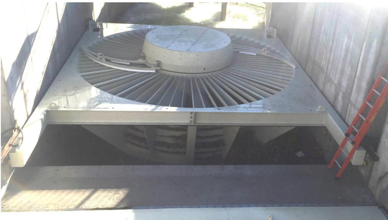
**Abb. 2** Die VLH - Turbine in horizontaler Lage nach Einheben während der Montage
