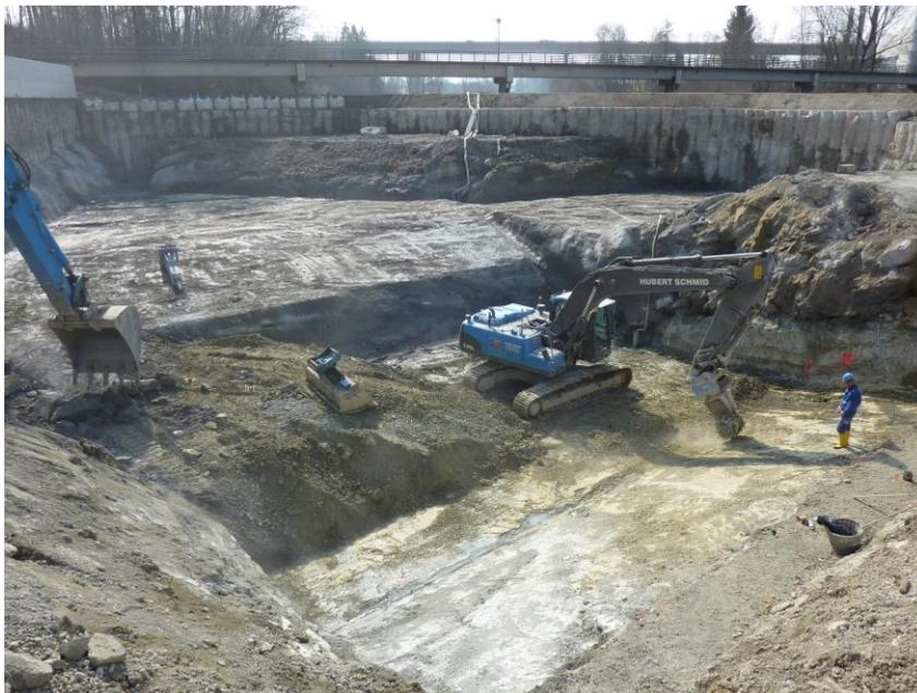
**Abb. 7** Die Baugrube für die Tröge des Kraftwerkes
