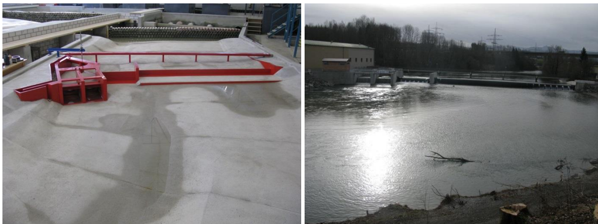
Abb. 1 Wasserkraftanlage Au an der Iller in Modell und Original vom Unterwasser
