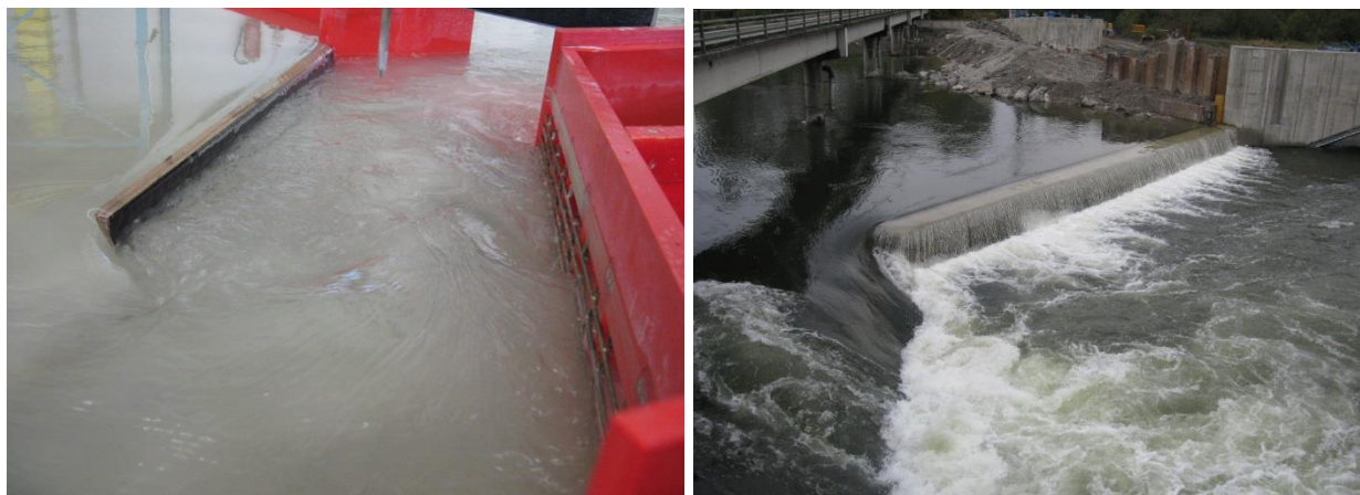
Abb. 8 Strömungssituation im Bereich der Leitwand bei geöffneter Kiesschleuse in Modell und Original
