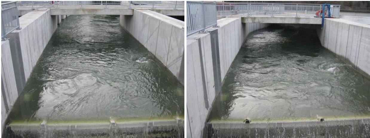
Abb. 5 Anströmung der beiden Turbinen im Original für den maßgebenden Lastfall (Blick entgegen der Fließrichtung, links: in Fließrichtung rechte Turbine)
