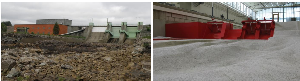
Abb. 2 Talsperre Degerforsen im ursprünglichen Zustand des Originals und im Ausgangszustand des Modells mit dem bereits eingebauten vierten Wehrfeld vom Unterwasser
