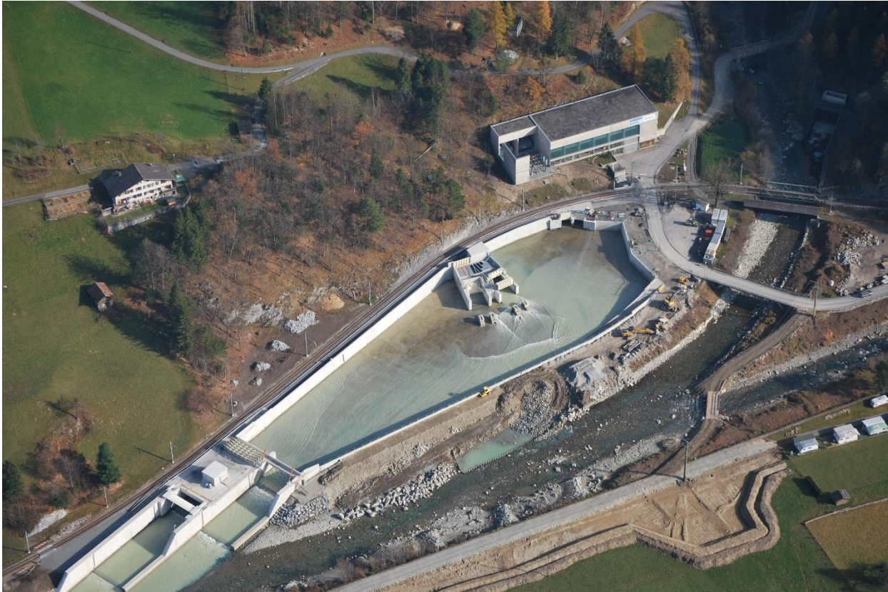
Abb. 2 Luftbild des fertiggestellten Ausgleichs- und Regulierbeckens Innertkirchen. Oben rechts: Kraftwerk Innertkirchen 2, Mitte: Ausgleichs- und Regulierbecken mit Auslauf- und Regulierbauwerk PUW, unten links: Wasserrückgabe über Auslauf- und Regulierbauwerk BB in die Hasliaare. Entlang des rechten Bildrands sind das Gadmerwasser sowie oberhalb der Bahbrücke das ehemalige Auslaufbauwerk des bestehenden Unterwasserstollens erkennbar.
