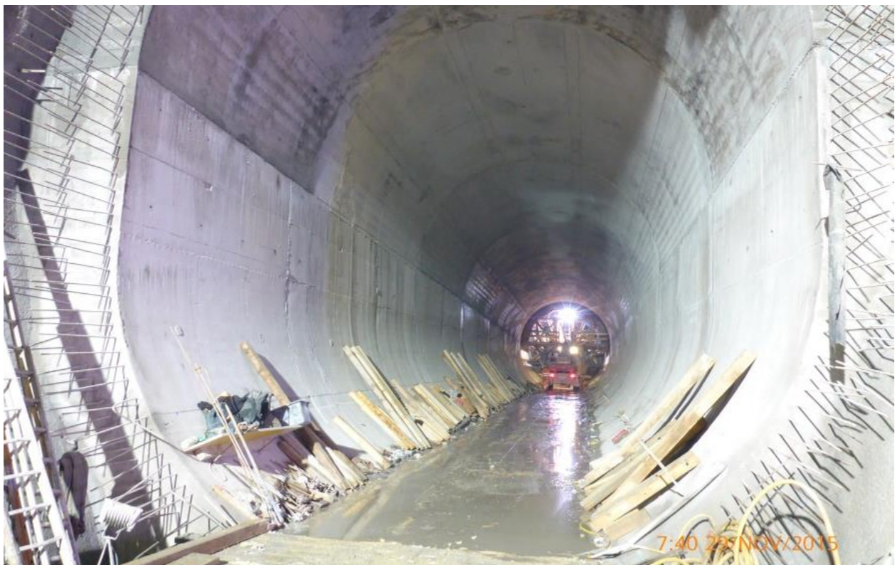
Abb. 7 Eine der unteren Kammern aus Sicht Steigschacht
