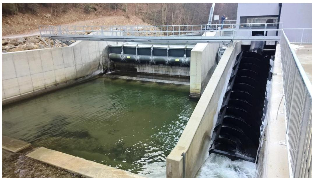
**Abb. 3** Restwasser-Wasserkraftschnecke beim KW Stubenberg/Feistritz
