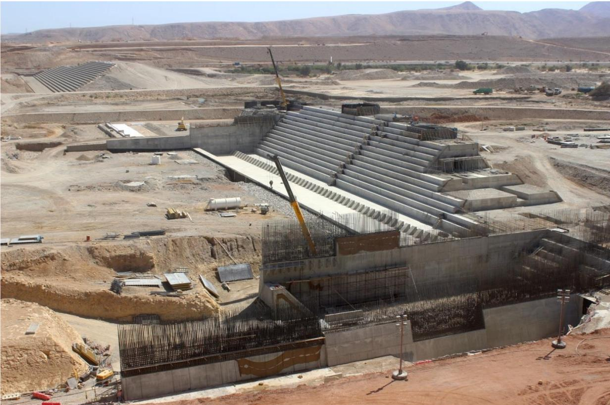
**Abb. 10** Bauarbeiten Hochwasserentlastung und Grundablass
