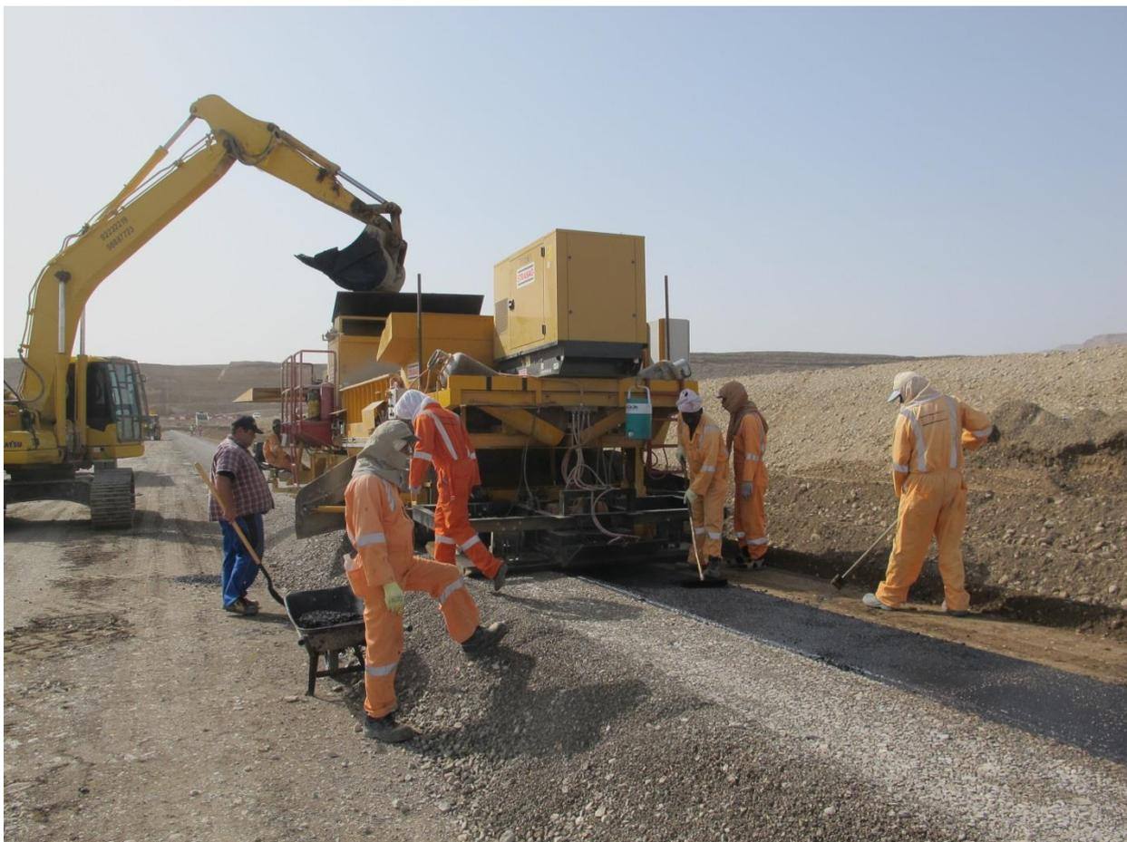
**Abb. 9** Asphaltbeton-Kerneinbaugerät
