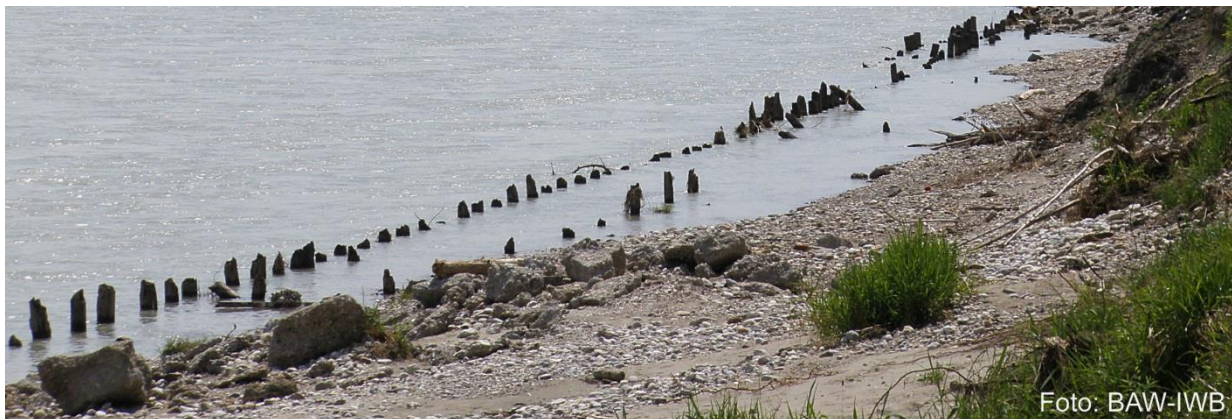
Abb. 10 Holzpfähle einer beim Hochwasser 2013 freigelegten alten Ufersicherung im Bereich des linken Ufers
