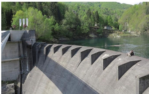
Abb. 3 Neue HWE der Stauanlage Palagnedra als freier Überfall (Foto: VAW, ETH Zürich).
