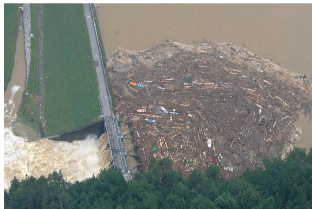
Abb. 2 Schwemmholz und Geschwemmsel vor der HWE des Thurnbergspeichers 2002 (Foto: Bundesamt für Land- und Forstwirtschaft, Umwelt und Wasserwirtschaft, A).
