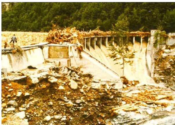
Abb. 1 Verklausung der HWE Palagnedra 1978 (Foto: Ofima, CH)
