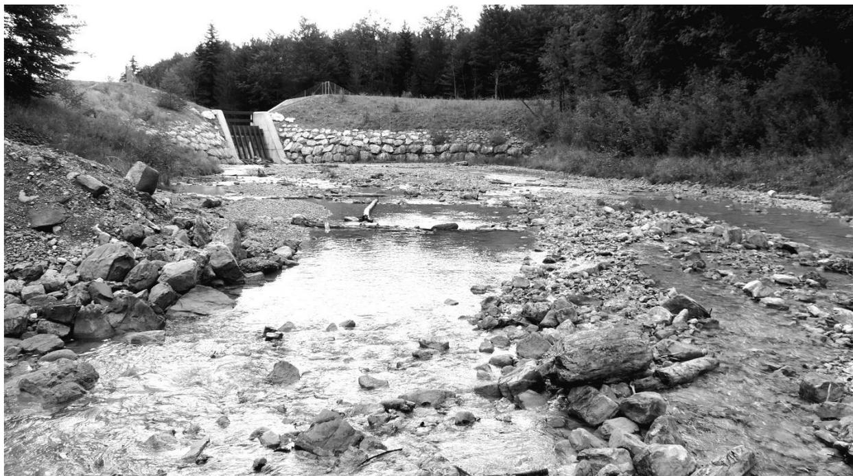
**Abb. 1** Geschiebesammler mit Ablagerungsplatz und Sperrbauwerk am Jenbach bei Bad Feilnbach (Blickrichtung unterstrom)
