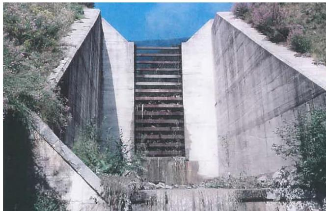
**Abb. 2** Kombination aus einer Schlitz- und einer Balkensperre; Quelle: (WEBER, 2006)
