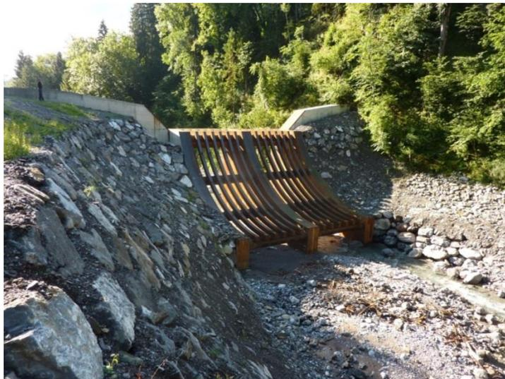
**Abb. 3** Rechensperre mit ausgerundeten MSH Stahlträgern (Bild: WLV Vorarlberg)
