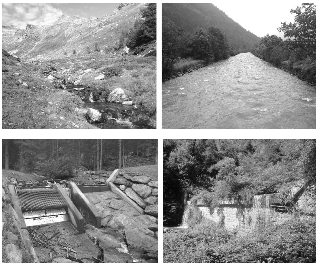
Abb. 2 Beispiele der untersuchten Fließgewässer (oben) und von Querbauwerken (unten)
