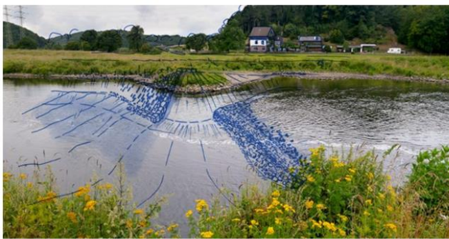
Abb. 5 Bühnendeckwerk und gepl. Umlagerung in die Flussmitte (schematisch)
