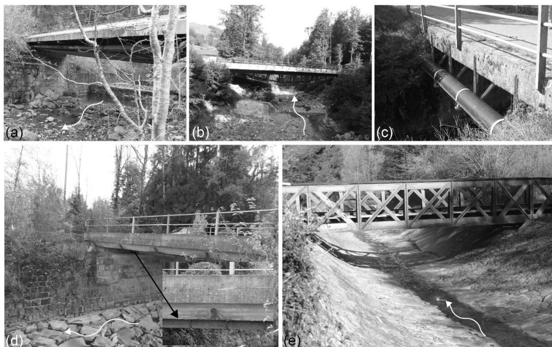
Abb. 4 Ungünstige Brückenquerschnitte im Projektperimeter. (a) Holzerbödelbrücke, (b) Hergiswaldbrücke II, (c) Fischerenbachbrücke, (d) Blattigbrücke, (e) SBB-Brücke.
