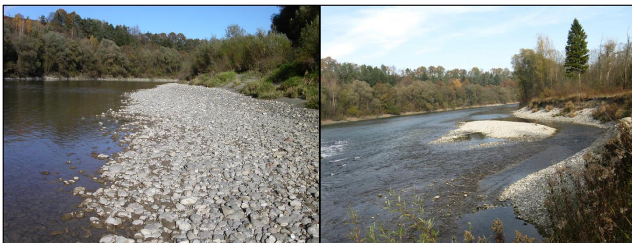
Abb. 2 Fotodokumentation der Uferentwicklung unterhalb der Schwelle bei Fkm 110 (Blick in Fließrichtung; links: Ufer vor Baumaßnahme (2002); rechts: Uferentwicklung durch Schüttsteinschwelle (2011)).
