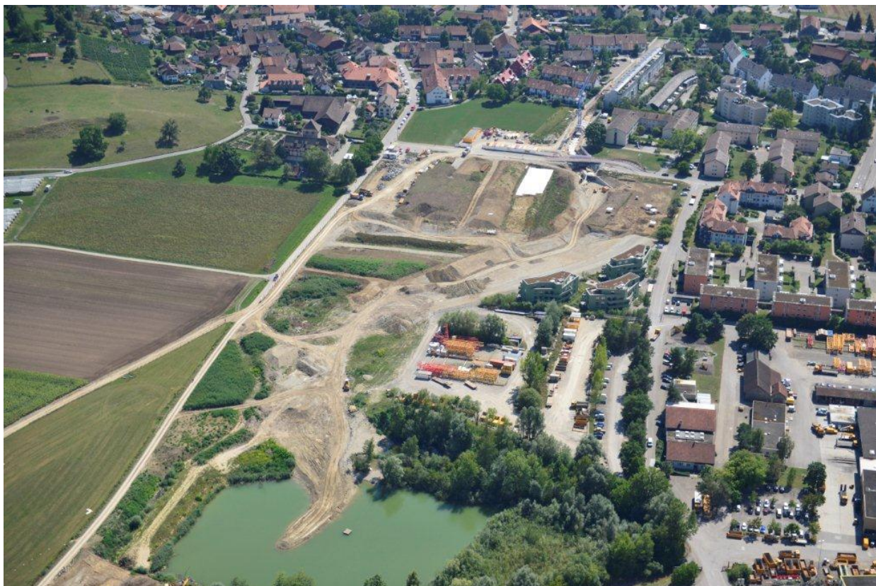
Abb. 1 Luftaufnahme Auslauf Zuflusskanal im Hintergrund in den Rückhalteraum (Quelle: Baudirektion Kanton Zürich)
