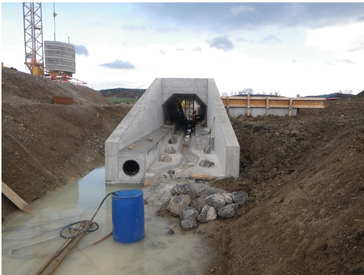
Abb. 4 Auslauf Durchlassbauwerk, Blick gegen Fließrichtung
