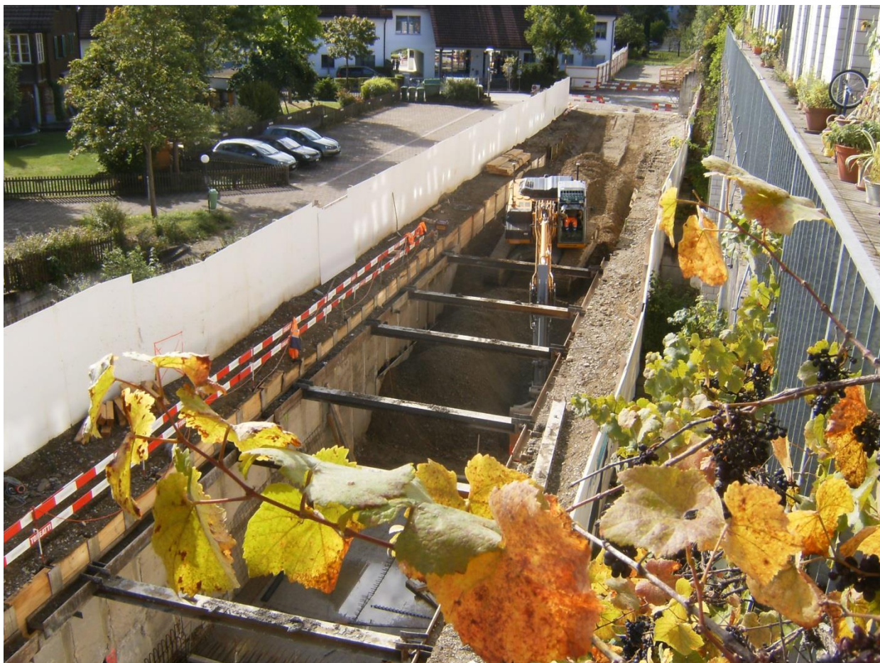
Abb. 5 Arbeiten an der Baugrube Zuflusskanal in unmittelbarer Nähe einer Liegenschaft
