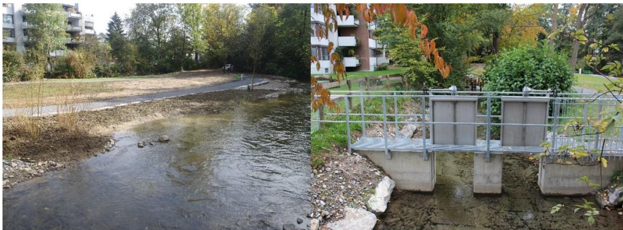
**Abb. 6** Flutmulde integriert im Ehret-Park und Drosselbauwerk mit Grobrechen
