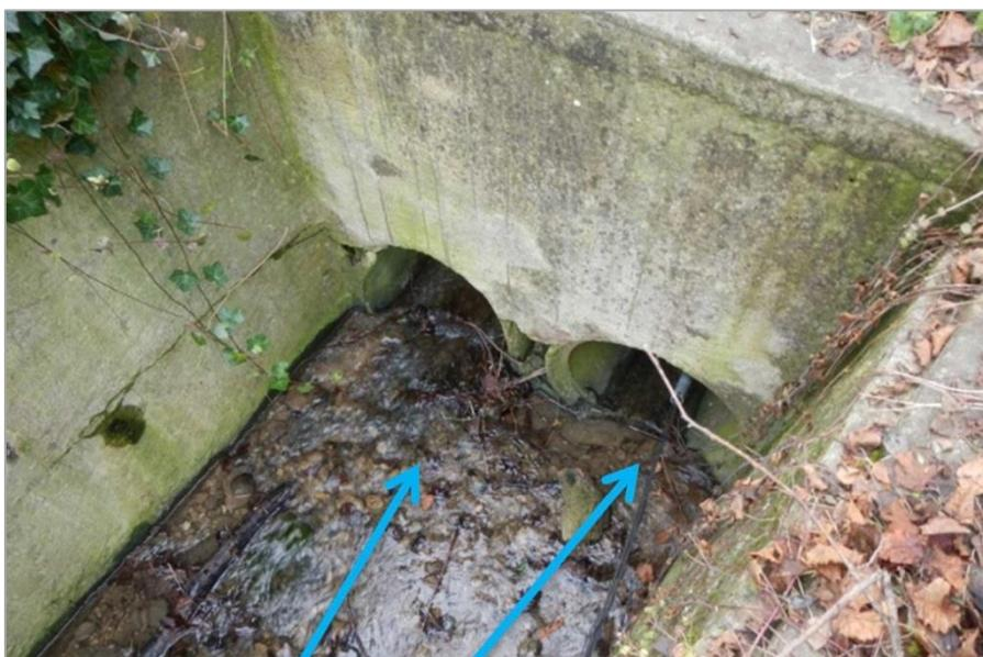
**Abb. 2** Durchlass mit geringer Kapazität, verklausungsgefährdet
